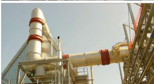
progetto e installazioni di compensatori angolari e laterali su tubazioni scarico turbine a vapore design and installation of hinged and lateral expansion joints on piping discharge steam turbine
