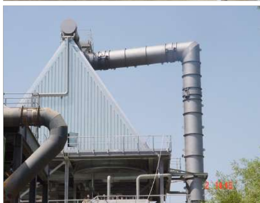
progetto e installazioni di compensatori angolari e laterali su tubazioni scarico turbine a vapore design and installation of hinged and lateral expansion joints on piping discharge steam turbine
